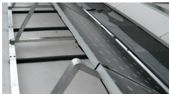
Billede 2: RENOLIT ALKORSOLAR som underlag for krystallinske solcellepaneler
