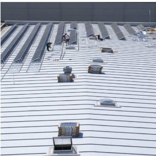
Krystallinske solcelle paneler monteres direkte på RENOLIT ALKORSOLAR systemet
