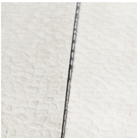
La instalarea unei membrane standard albe pentru acoperiș, sudurile se vor evidenția pe suprafața albă a acoperișului.
