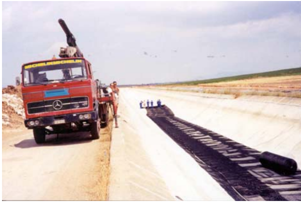
drainage sous étanchéité par géo-grille
