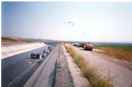
Soudure à air chaud avec double soudure
