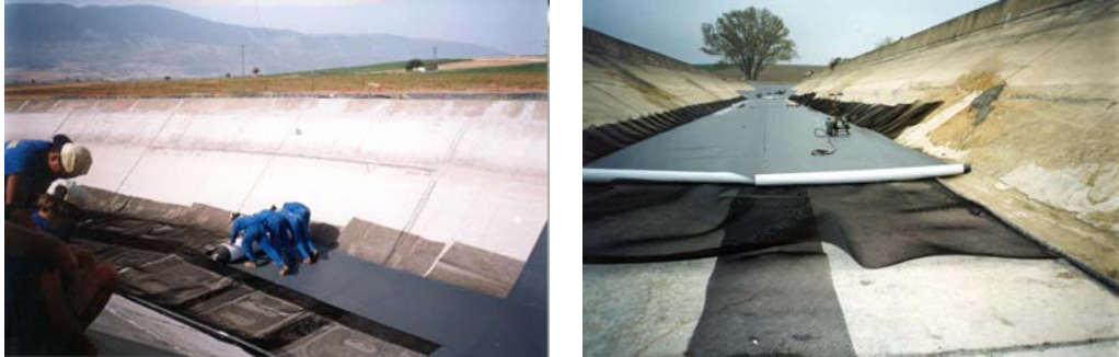
Déroulage et mise en place de la géomembrane
