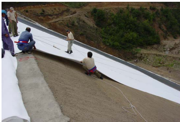
Mise en place du géotextile
