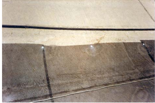
drainage sous étanchéité par géo-grille
