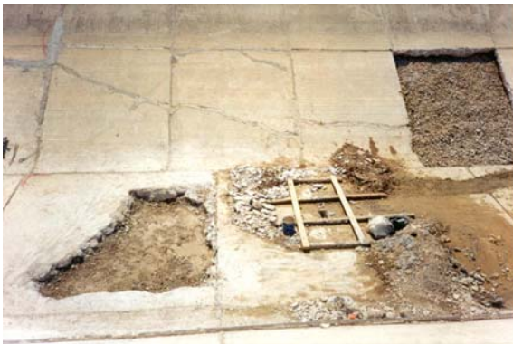
Réparation du lit du vieux canal et le nettoyage du support
