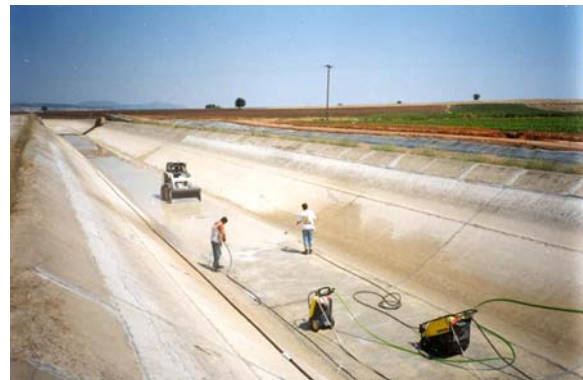
Réparation du lit du vieux canal et le nettoyage du support
