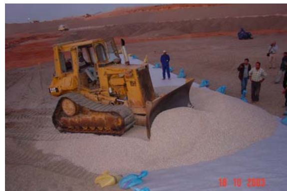
Répartition avec bulldozer
