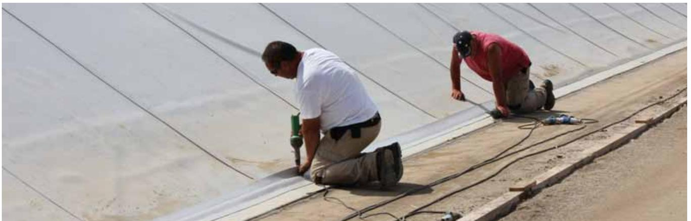
Soudure à air chaud avec double soudure
