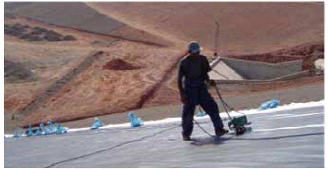
Soudure à air chaud automatique
