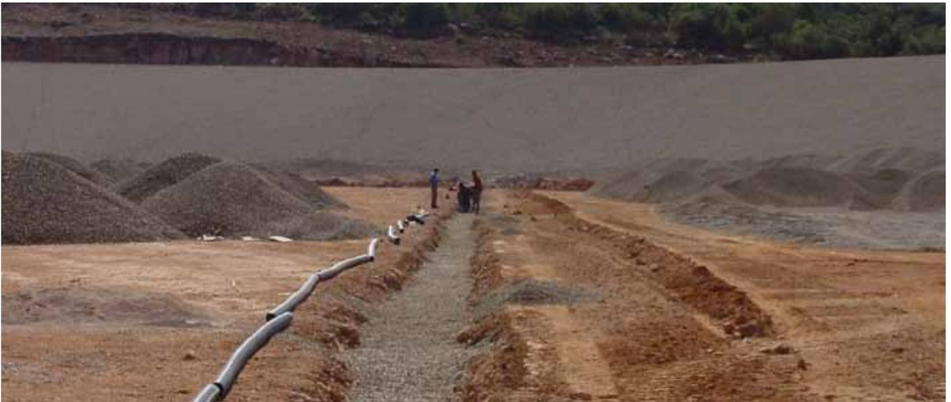
Tuyaux de drainage sous étanchéité
