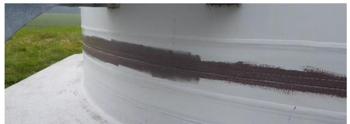
Auftrag des Primers über beide Schweißnähte
