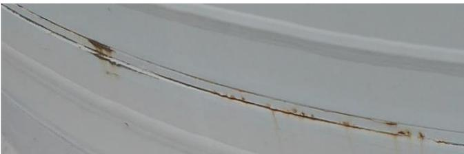
Sichtbare Korrosionsspuren im Flanscbereich
