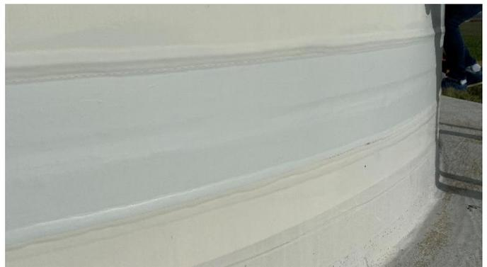
Hier sieht man die Standard-RAL-Farbe „Lichtgrau“ des Folienstreifens im Vergleich zu der ausgeblichenen Lackierung der Erstausrüstung, die ursprünglich den gleichen Farbton hatte.
